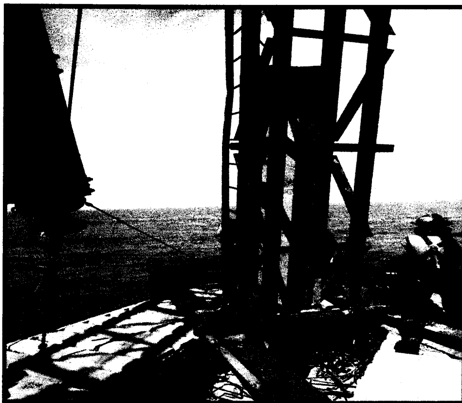
HINCADO DE PILOTE ENTRE LOS EJES 203 - 204
